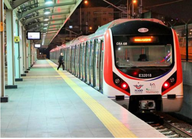
Marmaray Otomasyon Panoları Marmaray Automation Panels
